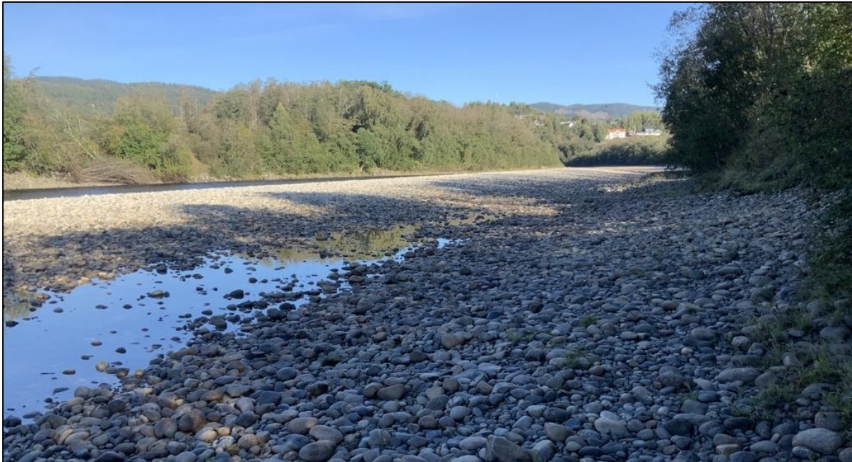
Figur 2-6 Det er planlagt omfattende erosjonssikring av elvebredden mellom Gyllan og Foss som medfører forringelse av flom- og kantskog, elvøer og gyteområder i Gaula. Bildet er tatt nedstrøms, dvs. nordover omtrent fra der Fossvegen kommer ned til dagens E6 (Foto: Norconsult)
